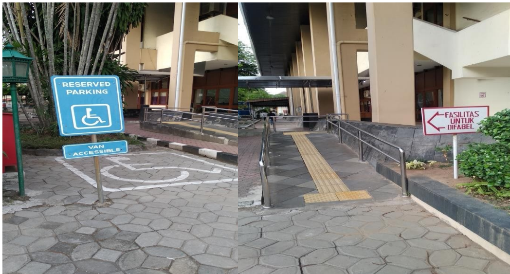
Gambar 3.49. Fasilitas Untuk Difabel
