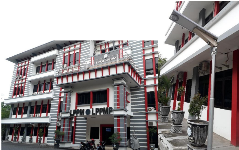
Gambar 3.16. Panel Surya untuk Penerangan Luar Ruangan di Gedung LPPM
