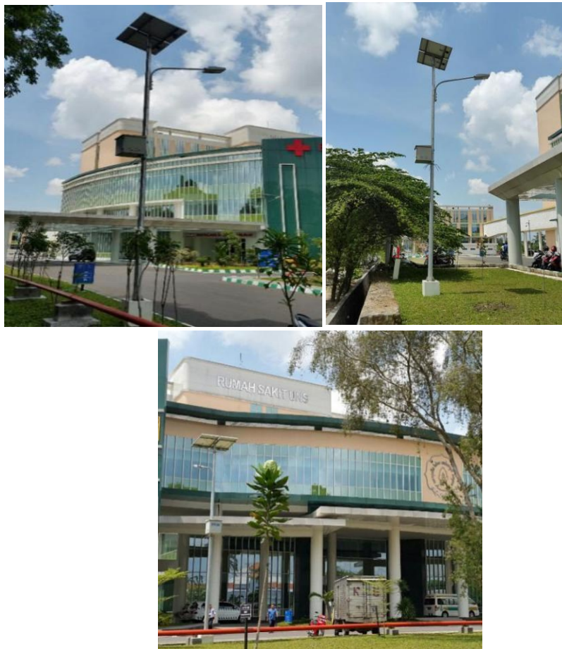
Gambar 3.15. Tenaga Surya Untuk Penerangan Lingkungan Luar Rumah Sakit Universitas Sebelas Maret
